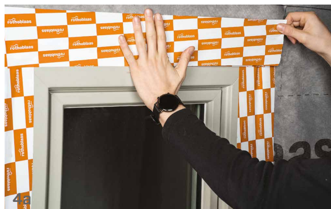
Запечатайте оконные стыки изнутри и снаружи.
