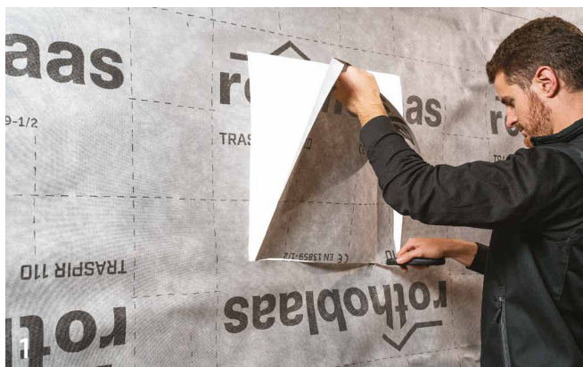
Вырежьте оконные отверстия.
